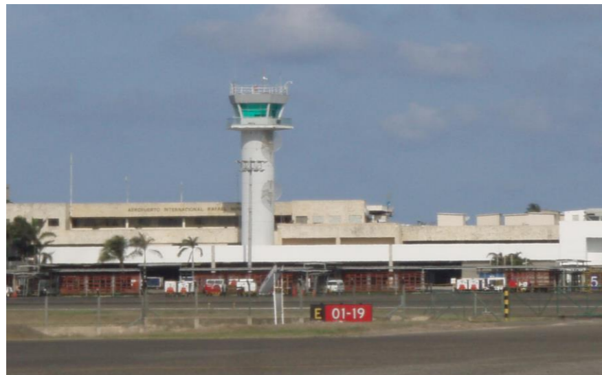
Ilustración 42 Torre de Control
