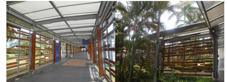
Ilustración 17 Pasillo de acceso junto a plataforma (Pérgola)
