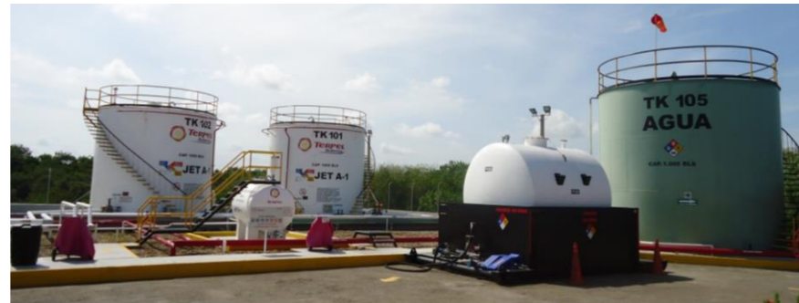
Ilustración 48 Zona de combustible junto a la plataforma ECHO
