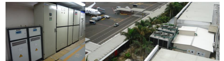
Ilustración 50 Interior de la subestación número 2 y transformadores
