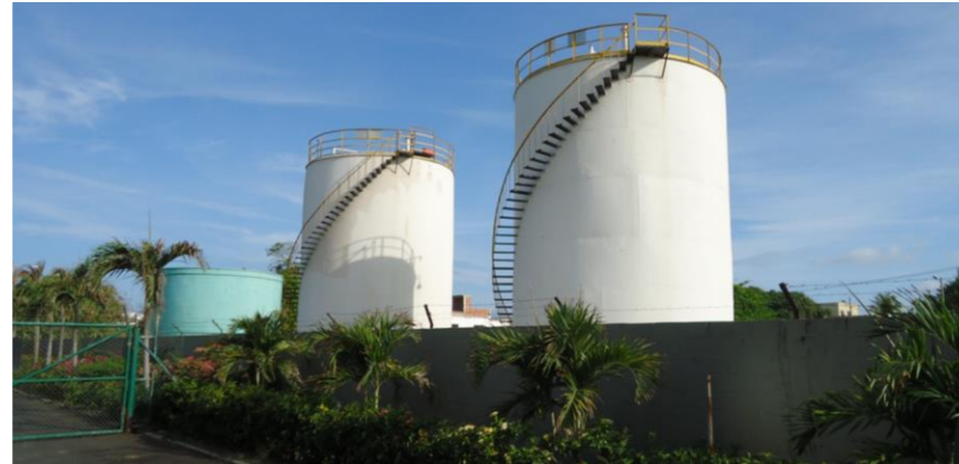
Ilustración 47 Depósitos de combustible al norte del Terminal
