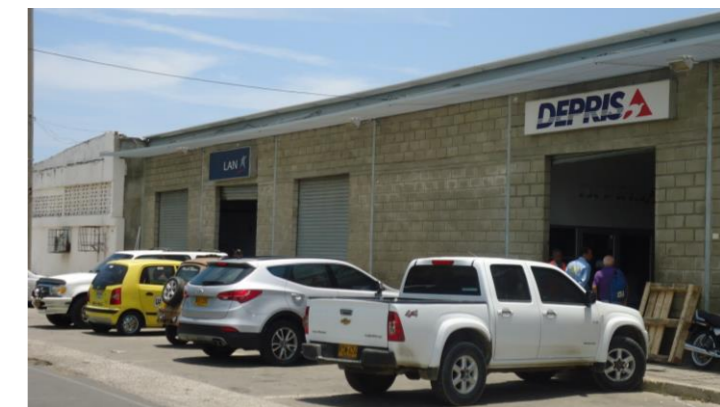
Ilustración 45 Acceso a las bodegas de carga desde lado tierra
